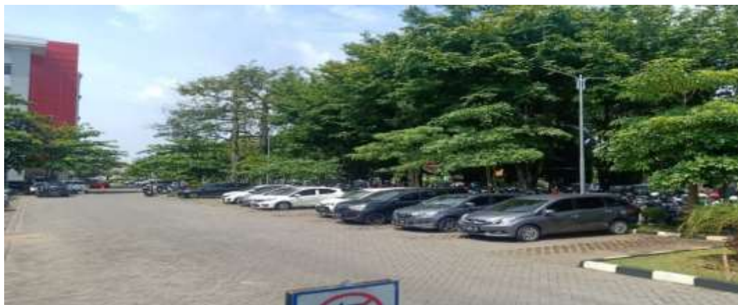
Gambar 1. Area Lahan Parkir yang Masih perlu Dilakukan Penghijauan dan Perbaikan Saluran Air
